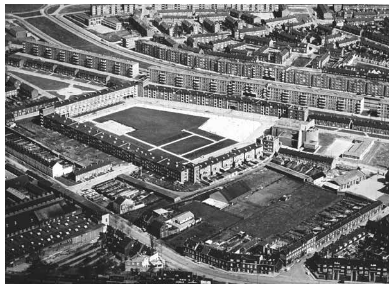
De inmiddels weer gesloopte flats aan de President Rooseveltlaan vlak na de bouw. Poorten in de bebouwing (Professor Quixstraat en Schepen Roosenstraat) moeten er voor zorgen dat de achterliggende wijken toch verbonden blijven met elkaar.
