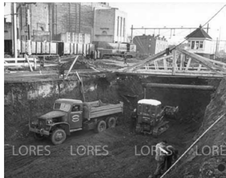
Aanbouw spoortunnel Scharnerweg
