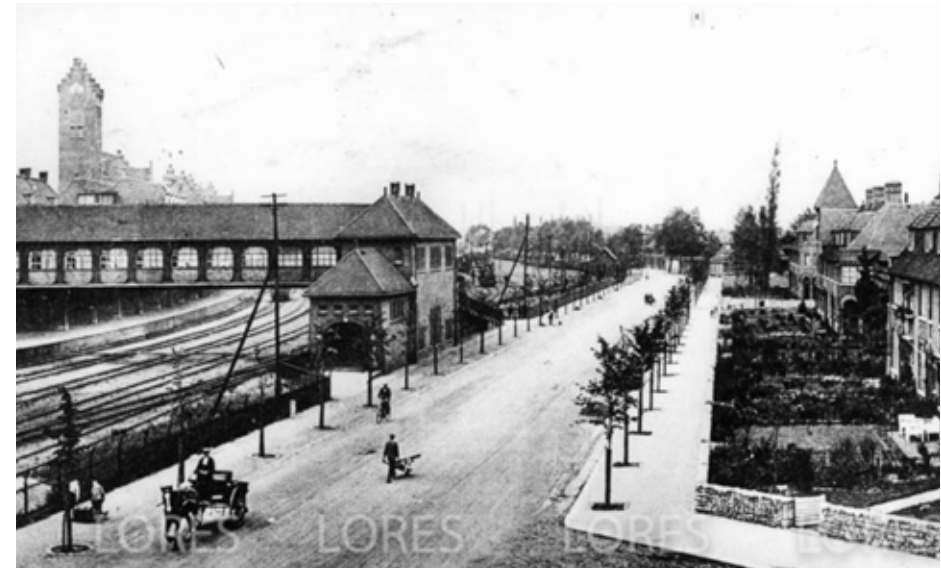
Links de afgebroken voetgangersbrug die uitkwam op de Meerssenerweg.
