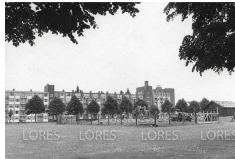
Aanbouw spoorwagentunnel Scharnerweg
